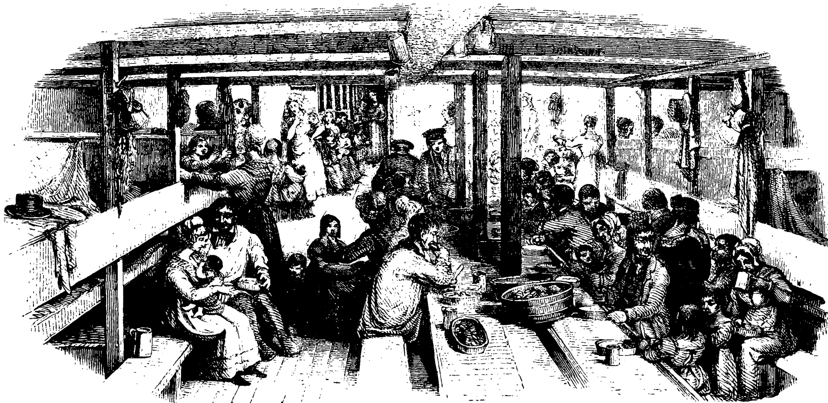
Aménagement intérieur d'un bâtiment américain frété pour la Californie.
