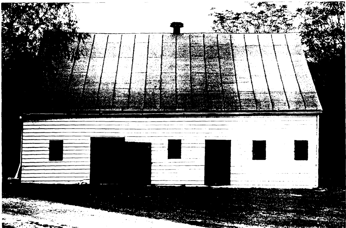
125-A Stable - West Elevation (RRA)
