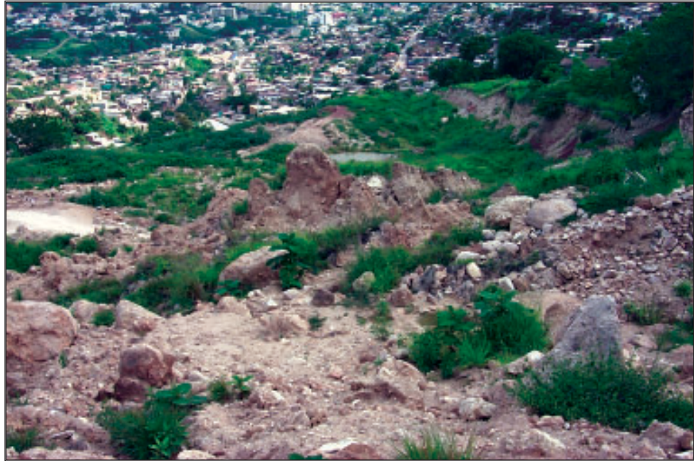
Figura 6. Área de la grieta frontal del deslizamiento de tierra de El Reparto en la que se puede apreciar un pequeño estanque en el centro de la fotografía.
