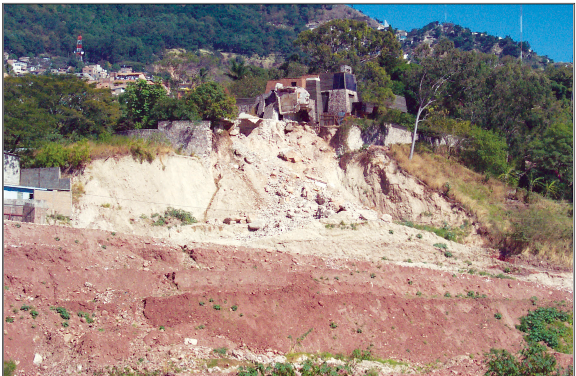
Figura 8. Deslizamiento de escombros del Barrio Mira Mesi que después del paso del huracán Mitch ha logrado avanzar aún durante la estación seca, a pesar de la colocación de una berma de tierra (al frente) para proteger la pendiente.
