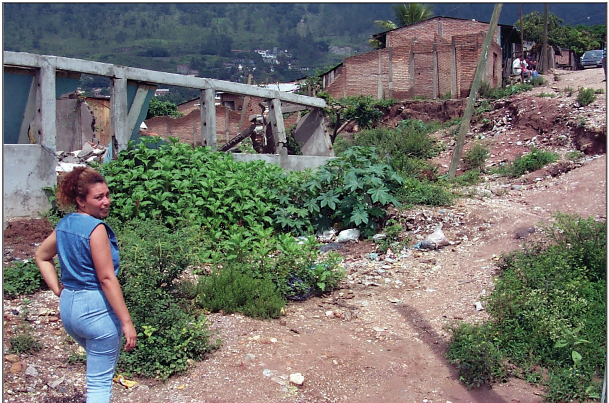
Figura 10. Reactivación de un hundimiento en el Barrio Santa Rosa como consecuencia de las intensas lluvias ocurridas durante septiembre de 1999.
