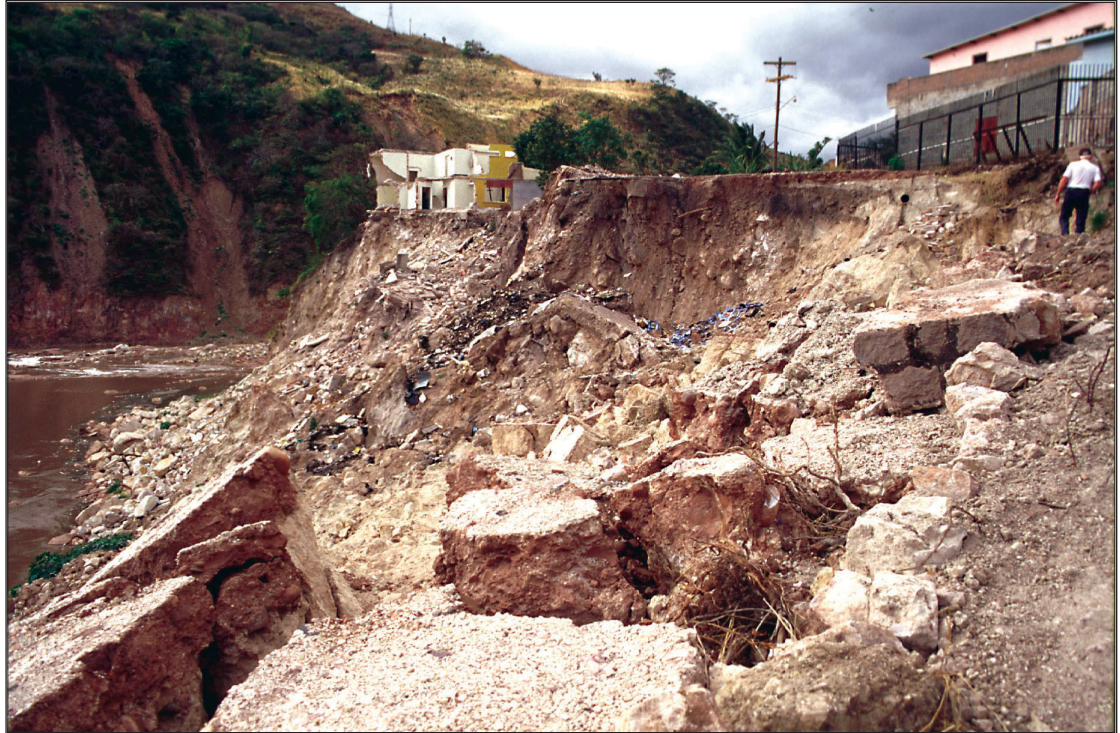
Figura 7. Deslizamientos de escombros en el Barrio Mira Mesi, adyacente al Río Choluteca.
