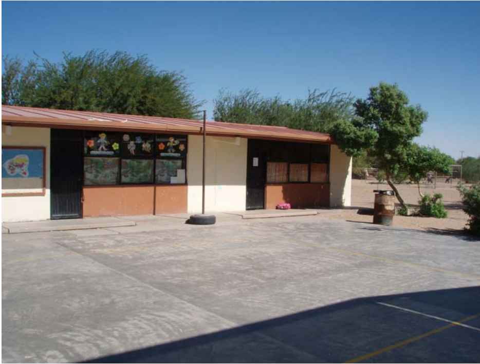
Figura 7. Escuela en La Grullita. Se colocó un monitor en la oficina del Directo del plantel.
