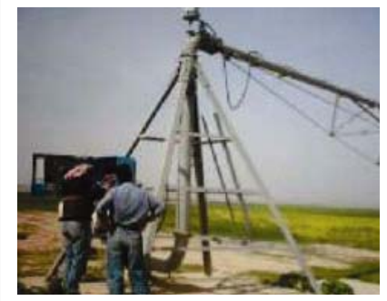
يساعد مختصي الوكالة الأمريكية للتنمية الدولية USAID احد المزارعين في تركيب نظام الري مركزي المحور .
