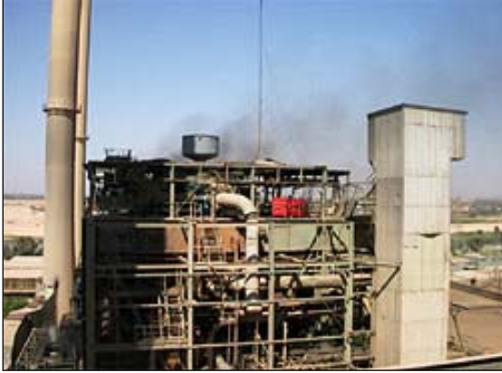
وحدة المراجل في مشروع الدورة الحراري للطاقة الكهربائية في بغداد. الصورة : USAID
