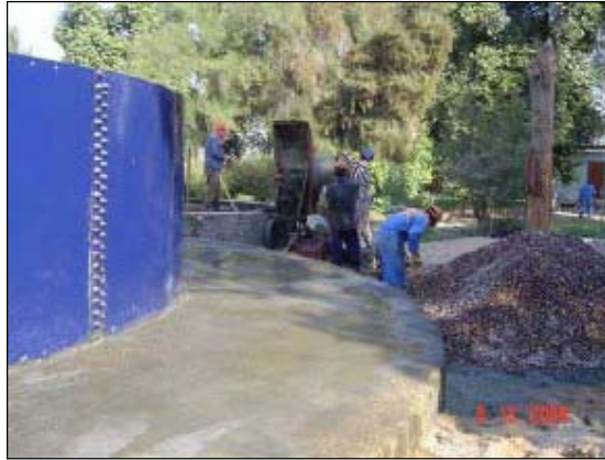
الاعمال المستمرة في محطة البصرة الحرارية للطاقة الكهربائية.
