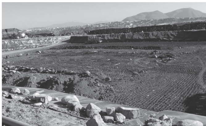
Sitio de Metales durante la fase de construcción
