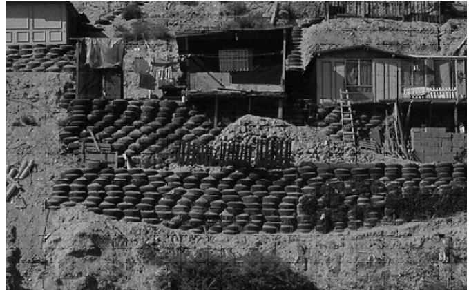
Llantas usadas en sitios propensos a la erosión
