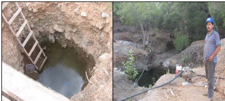
San Jose de la Zorra, Izquierda: Una noria hecha a mano; derecha: Pozo Agrícola utilizado ocasionalmente para beber agua potable
