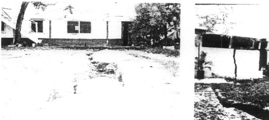
Figura B. 4 y Figura B. 5: Daños causados por la licuación en Changuinola, Panamá durante el Terremoto de Limón, 1991
