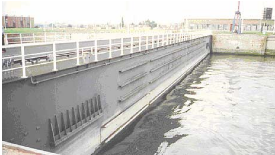
Figura 8. Compuerta deslizante en la esclusa de Berendrecht
