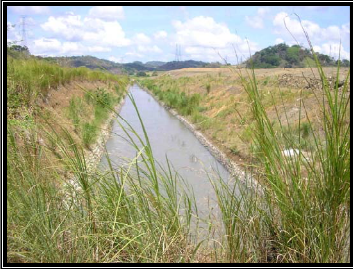
Foto 5. Sitio T6. Canalización de curso de agua en el área.
