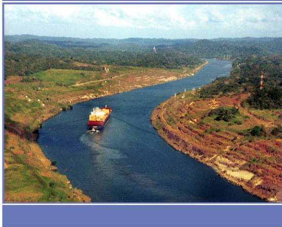
Figura 4-12 Vista del cauce de navegación del Canal en el Corte Culebra. Se observa un buque girando en la curva de La Pita.
