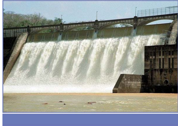
Figura A-32 El vertedero de la represa de Miraflores se utiliza para controlar el nivel del lago Miraflores.
