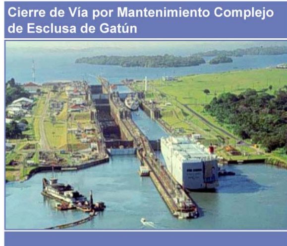
Figura 4-14 Vista de la esclusa de Gatún donde se puede observar un cierre por mantenimiento de la vía Este. La vía Oeste continúa operando para el tránsito de buques mientras se realizan estos trabajos.
