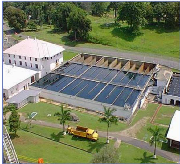
Figura A-42 La planta potabilizadora de Monte Esperanza abastece de agua potable a la ciudad de Colón y a las instalaciones de la ACP en el lado Atlántico.
