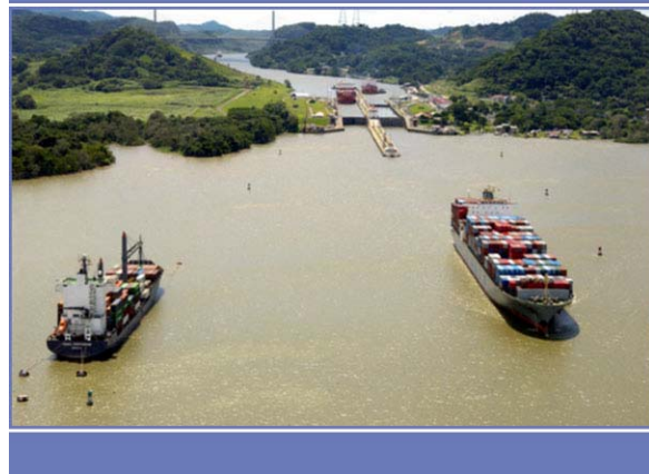
Figura A-16 El lago Miraflores divide las esclusas del Pacífico en dos secciones: las Esclusas de Pedro Miguel y las Esclusas de Miraflores.
