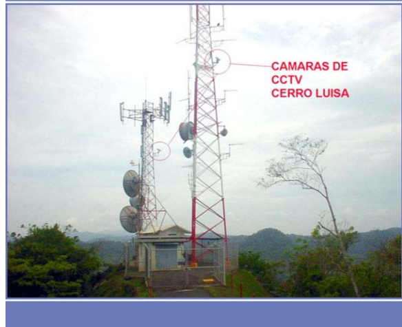
Figura A-25 Torre de comunicación en Cerro Luisa.
