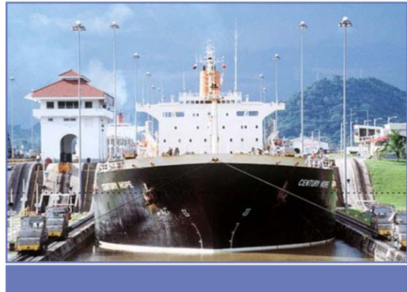
Figura A-51 La manga máxima permitida de 32.3 m (106') es limitada por el ancho de las cámaras de las esclusas.
