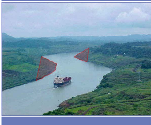
Figura 8-16 Curvas de las bordadas de Lirio y La Pita Sur, que forman parte del proyecto de enderezamiento del Corte Culebra.
