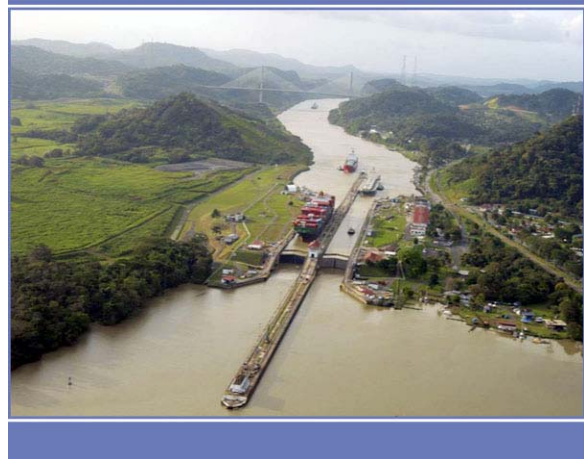
Figura A-7 La Esclusa de Pedro Miguel se ubica a un extremo del Corte Culebra y consiste de un solo nivel.
