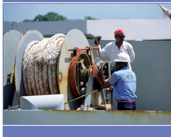
Figura A–22 El Canal cuenta con un total de aproximadamente 1,140 pasacables principalmente para asegurar los buques a los remolcadores y locomotoras.
