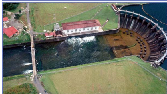
Figura A-37 La planta hidroeléctrica de Gatún aprovecha parte del excedente de agua durante la época lluviosa que es vertida del lago Gatún al Océano Atlántico para generar energía eléctrica.
