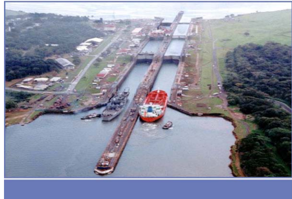
Figura A-6 Las Esclusas de Gatún es el más largo de los tres complejos de esclusas y consiste de tres niveles.
