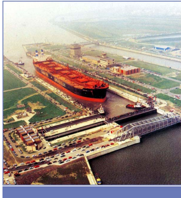
Figura 6–28 Uso de remolcadores como sistema de posicionamiento de buques en las esclusas pospanamax de Berendrecht, Bélgica
