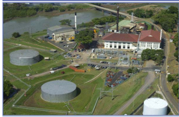
Figura A-39 Con una capacidad de 115 megavatios la planta termoeléctrica de Miraflores es la más importante del Canal. A diferencia de las plantas hidroeléctricas la estación seca no afecta su capacidad.
