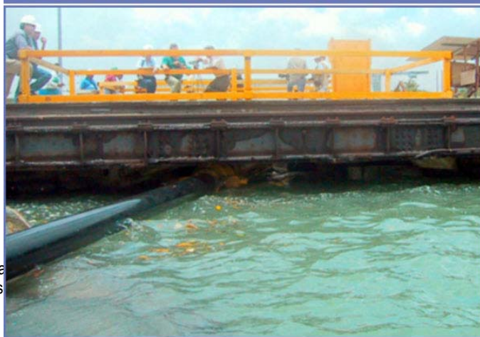
Figura 5-17 Brazo hidráulico que opera las compuertas con el sello para prevenir la entrada de agua por la elevación del nivel del lago Miraflores.
