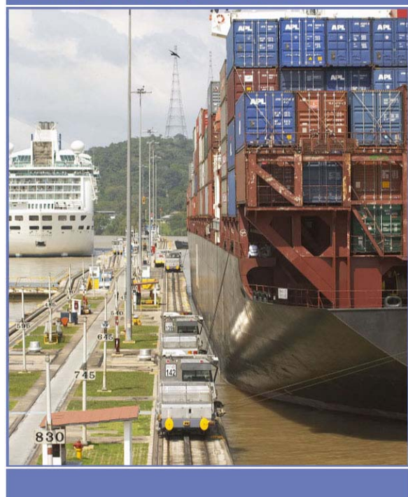
Figura 4-10 La foto muestra un buque porta contenedor Panamax en dirección norte en la esclusa de Pedro Miguel. Se observa el escaso espacio libre (aproximadamente 0.60m) entre el casco del buque y la pared lateral de la esclusa.
