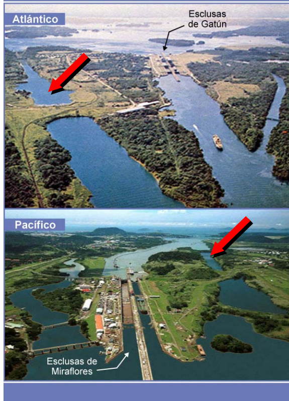
Figura 33 El proyecto del tercer juego de esclusas se construirá en el sitio de las excavaciones de 1939 dentro de áreas de funcionamiento del Canal.
