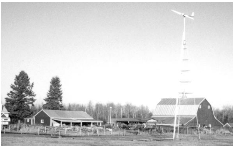
En Clover Valley, Minnesota, esta turbina eólica Whisper H175 de 3 kilowatts, se encuentra instalada en una torre de 50 pies, conectada a la red para compensar el suministro de energía de la red convencional.
