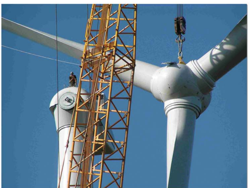
Hoisting Blade Assembly
