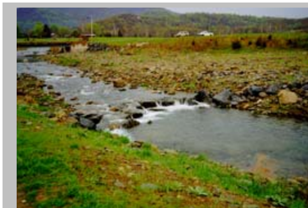
Fig. 2.3-11 Rock Weir, Rose River, VA
