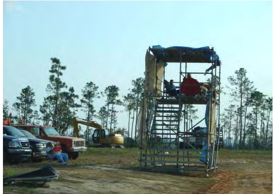
Esta torre está hecha para inspeccionar los camiones de escombros que se dirigen a los botaderos. El inspector está expuesto al tráfico vehicular que viaja cerca de la torre. Observe en esta foto la falta de una zona de protección alrededor de la torre. Debería haber marcas visuales como conos, señales o cintas para que los conductores puedan identificar la torre.
