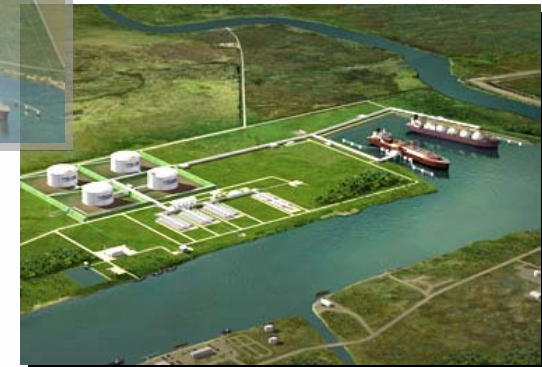
Creole Trail LNG Terminal
