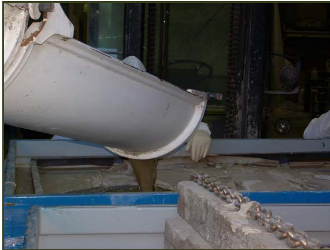
Second grout pour
