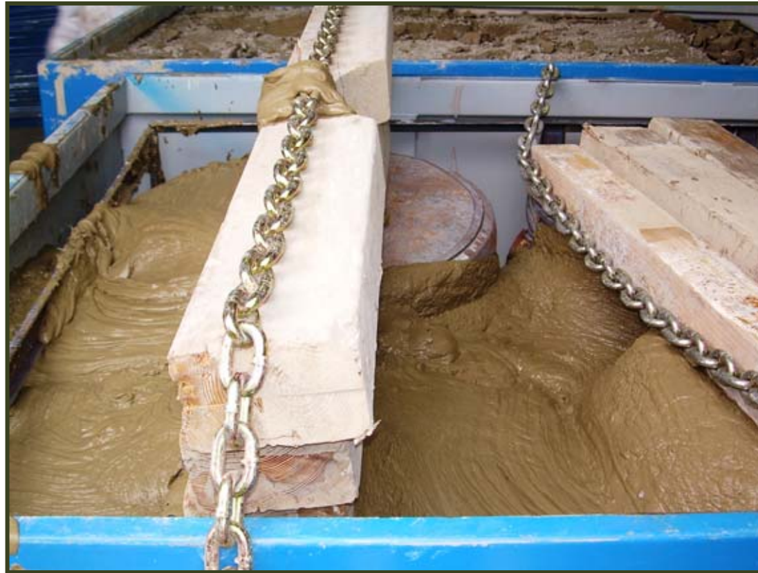
First grout pour completed
