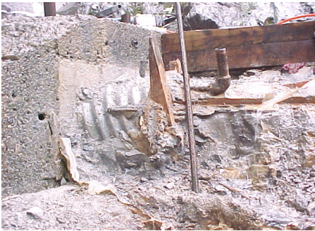
Conduit 3-196 exposed, downstream end.
