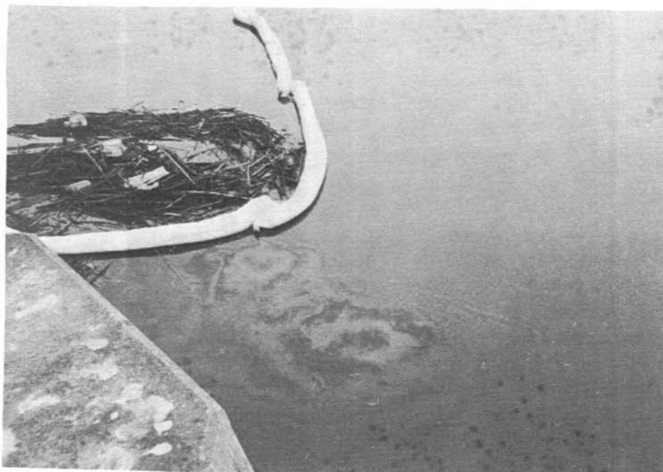
Foto 14. - Conducto de toma--aro recuperador de aceite. La nata se hunde por reposar el aro sobre derribos. 18/1/91
