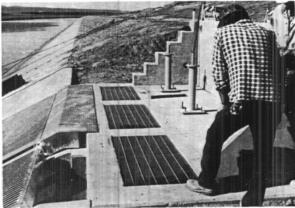
Figura 17.- Vista de las rejillas para basura y de las rejas.
