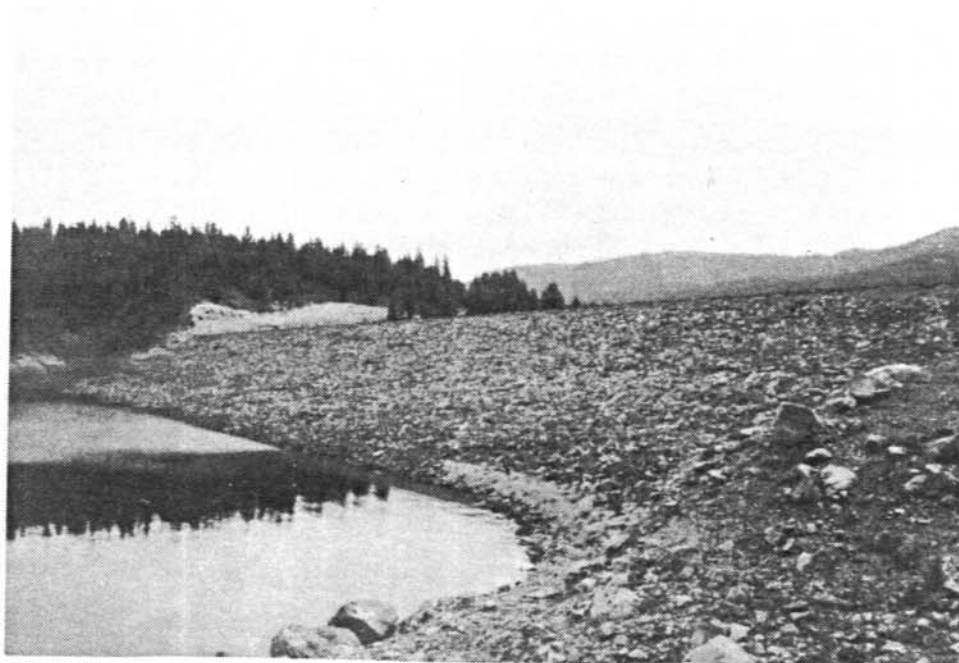
Figura 3.- La Presa Stampede - Depósitos de arena a lo largo de la cara de aguas arriba de la presa. 10/5/90
