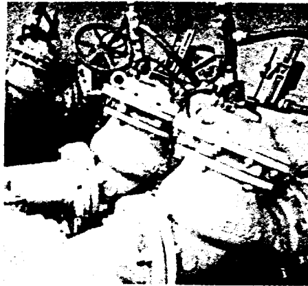
Tres válvulas de refuerzo para control de bombas controlan tres bombas separadas
