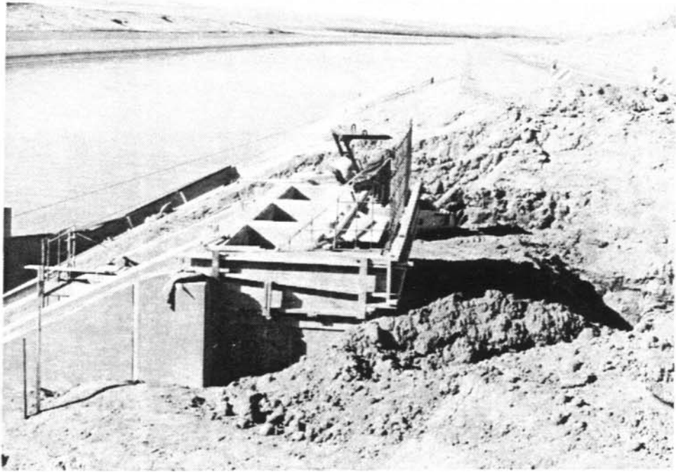
Figura 14.- Se nivela la tierra alrededor de la toma.
