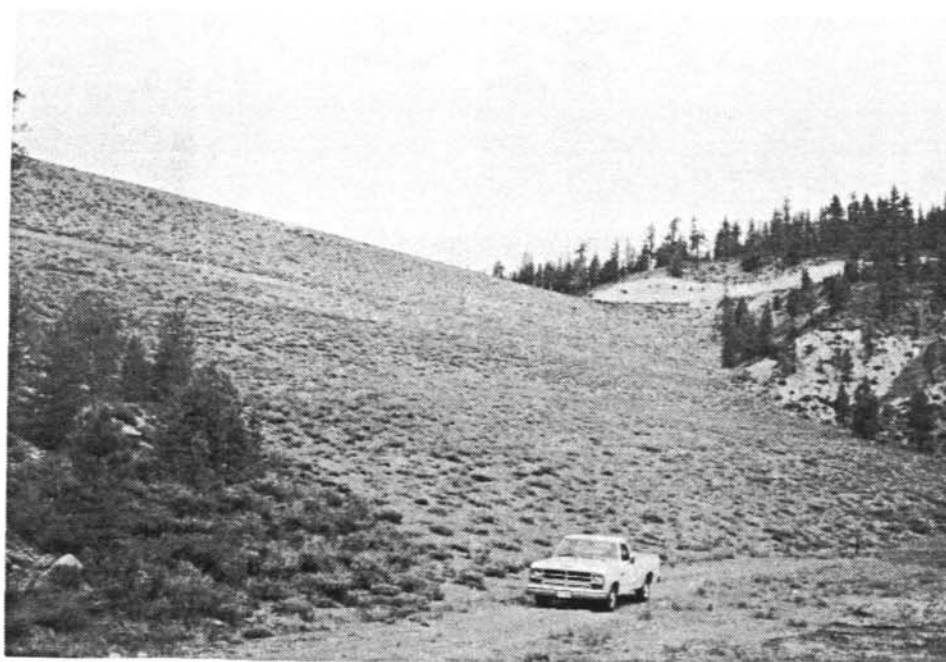
Figura 4.- La presa Stampede - La cara de aguas abajo de la presa cubierta con ligera vegetación. 10/5/90
