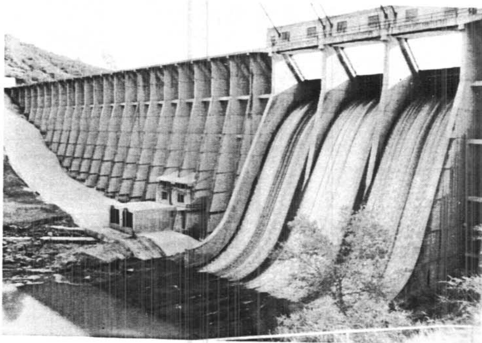
Figura 2.- Vista tomada aguas abajo de la presa de Stony Gorge mostrando la protección contra la submersión en la base de la presa. Foto por Joan Goodwin. 26/10/89
