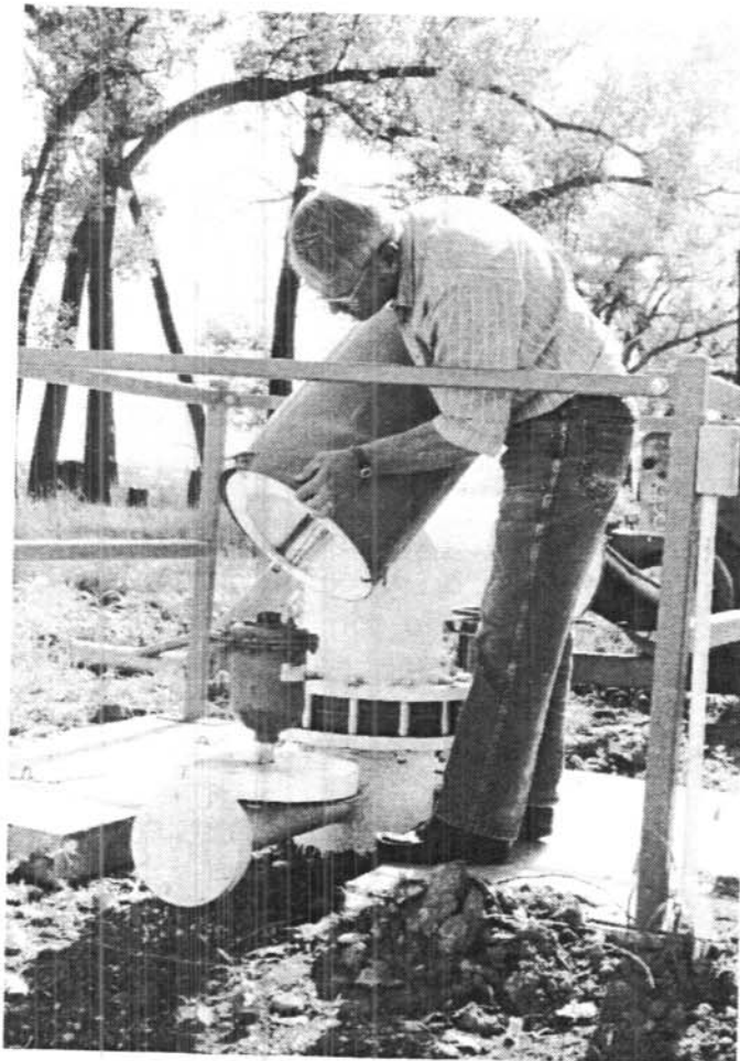
El tecnólogo, Paul Ewashen, demuestra la facilidad con que se puede remover el bote aislado para inspeccionar la válvula.
