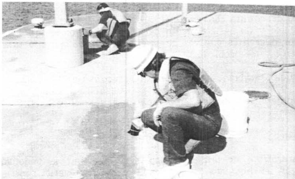
Prueba en sitio de un sellador penetrante para el hormigón. Esclusa y presa de Brandon Road, Distrito de Rock Island, Illinois.
