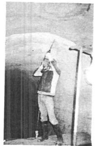
Figura 6.- También se barrenaron hoyos en el interior del túnel, inyectándoles resina. Se ve aquí, exudando de la junta, la resina inyectada desde el exterior del portal del tunel.
