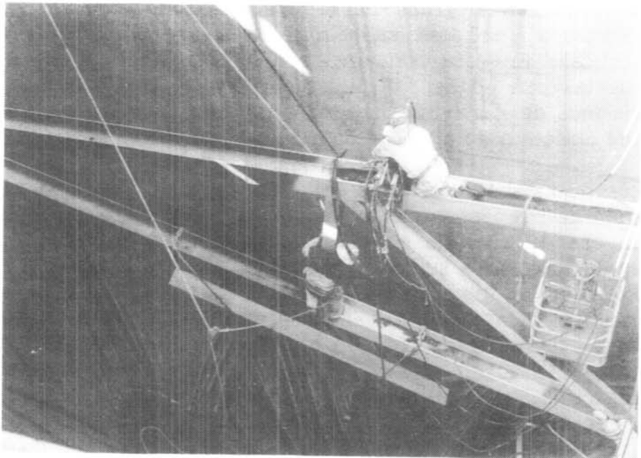
La metalización. La lona Envirotarp está colocada debajo del sitio de trabajo para recoger abrasivos y derrames
