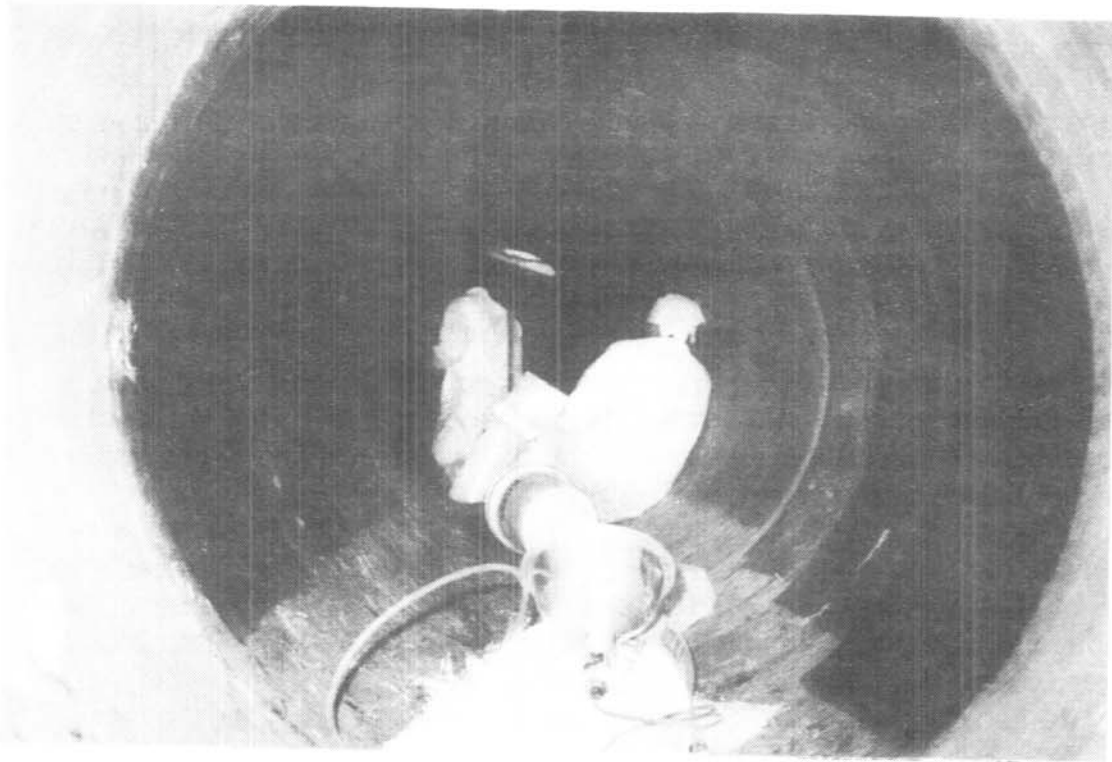
Figura 5.- Dos capas de hebras se aplican (arriba) y se dejan curar. Para completar el recubrimiento, se aplicarán dos capas finales con aditivos resistentes a la abrasión y sellantes de cera.
