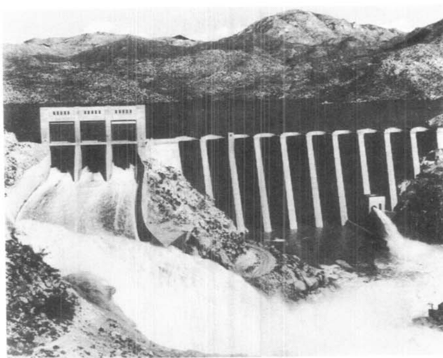
Figura 2.- La Presa Bartlett con el embalse lleno y una descarga de los vertederos de aproximadamente 396 \text{ m}^3/\text{seg} . 15/4/41
