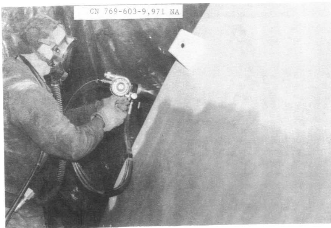
Foto 4.- Aplicación de la capa inicial de alambre de cinc por aplicador Metco de gas. La sección de 61 cm de ancho había sido limpiada por arenado antes de la metalización. Se alimenta el alambre por la parte trasera del aplicador, con el acetileno y el oxígeno provistos por las mangueras adaptadas al aplicador.
