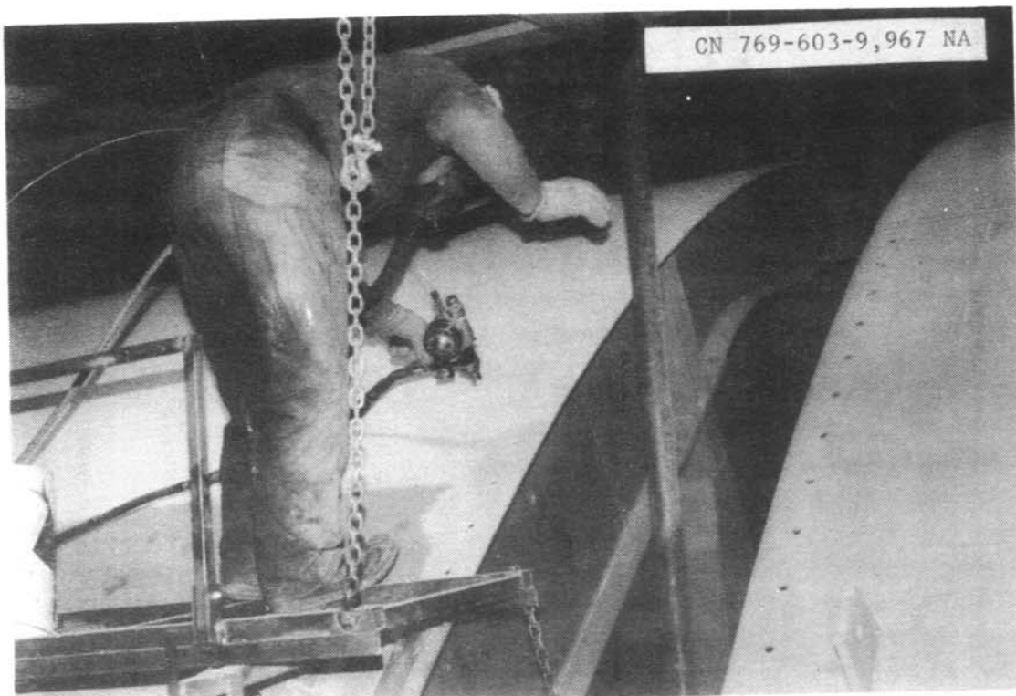
Foto 3.- Canal McClusky. Aplicación del cinc sobre la compuerta Norte. Nótese la posición de la pistola metalizadora. 8/3/89
