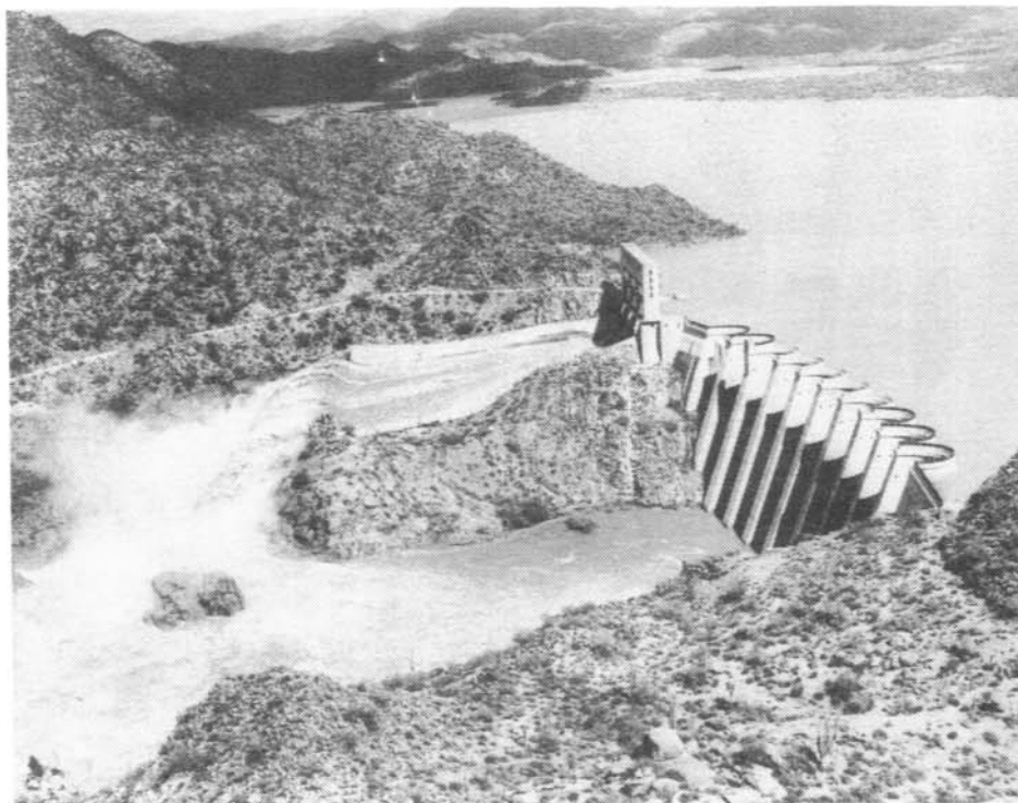
Figura 4.- Vista aérea de la Presa Bartlett mostrando una descarga aproximada de 1980 \text{ m}^3/\text{seg} saliendo del embalse llenado por recientes aguaceros. 3/3/78
