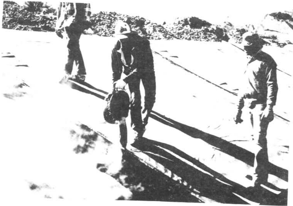
Impermeabilización de las juntas
