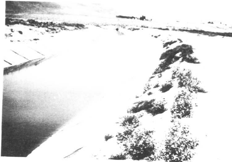
La obra acabada, el canal principal
