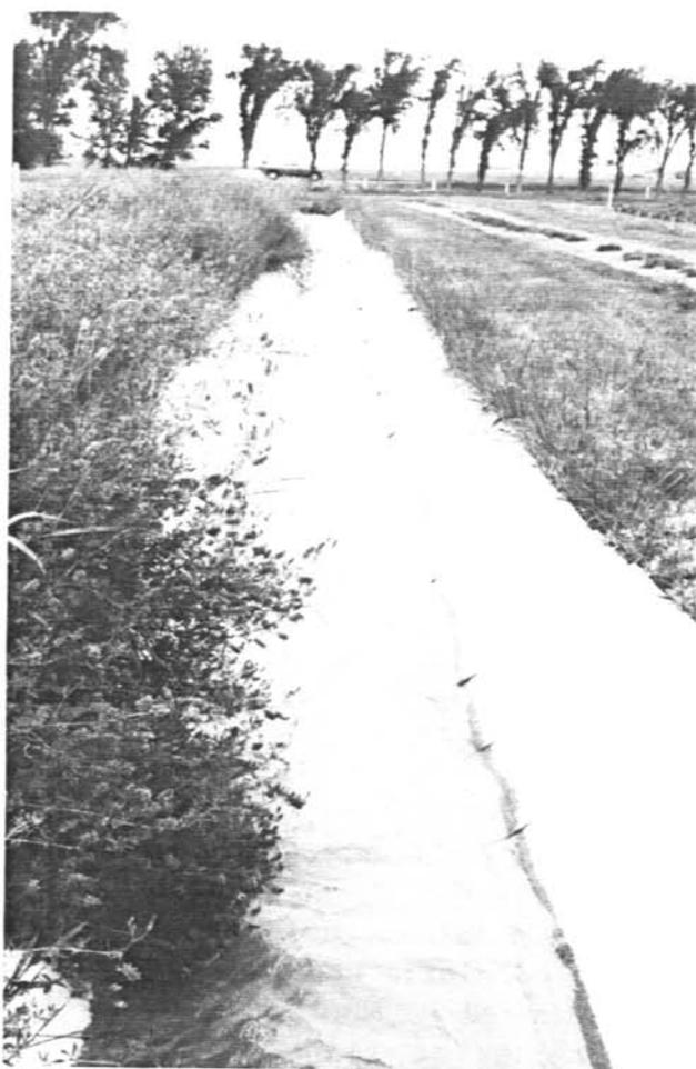
Los bloques de acera, por no estar pegados en sus extremos, no han sufrido ningún agrietamiento ni desalineación por el hielo
