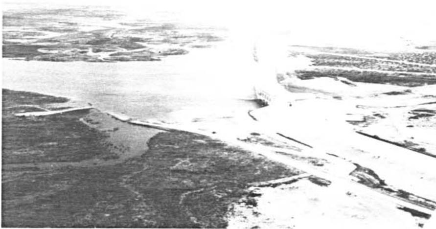
**Figura 6.- Presa Brantley - Vista aérea de la presa y el embalse. El lago McMillan se ve al fondo. Nótese la curva de los estribos de tierra. 29/9/88**
