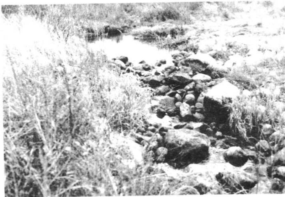
Figura 2.- El salto de rocas en el Dren Hays No. 64 ha logrado detener la erosión - con un excelente recrecimiento vegetal.
