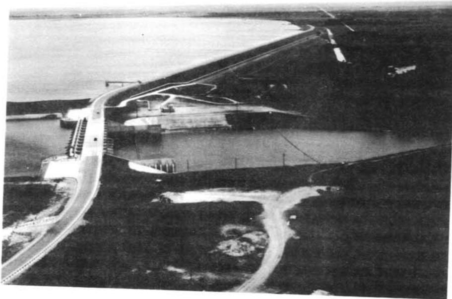
Foto 3.- Presa de Palmetto Bend, Texas. Vista aérea del aliviadero, las instalaciones de desagüe hacia el río, las tuberías y los parques de estacionamiento al oeste. 9/86
