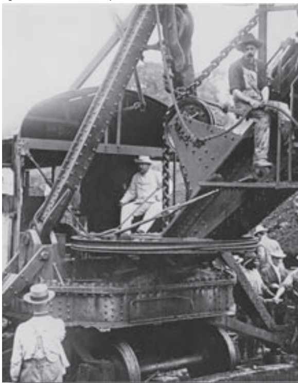
El presidente Theodore Roosevelt (en el centro) prueba el funcionamiento de una excavadora mecánica en el brazo Culebra durante la construcción del Canal de Panamá, proyecto que él defendió, en noviembre de 1906. Su visita a Panamá le convirtió en el primer presidente estadounidense en viajar al exterior. AP/WWP
