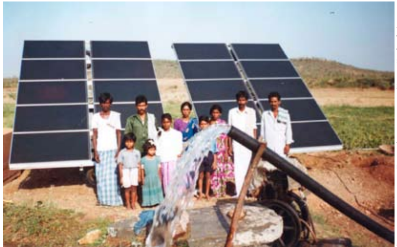
Нанос, питаемой солнечной энергией, смонтированный в Индии в рамках проекта Агентства Индии по освоению источников возобновляемой энергии.
