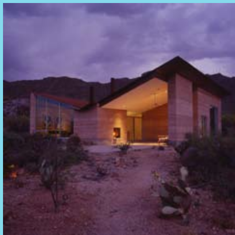
Дом с глинобитными стенами, построенный в горах в г. Тусоне по проекту Рика Джоя.
