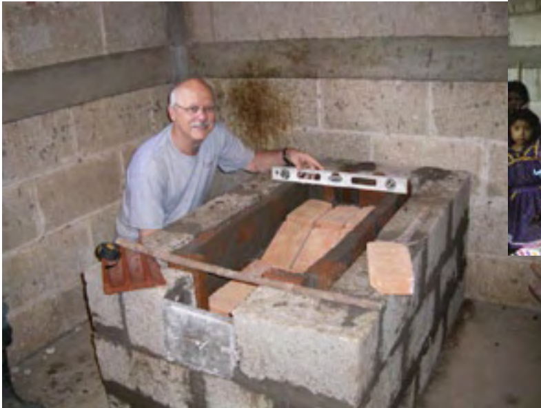
Un travailleur bénévole construit un fourneau doté d'un mécanisme de ventilation pour réduire la fumée à l'intérieur de la maison.
