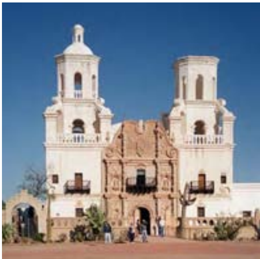
La mission de San Xavier del Bac près de Tucson (Arizona) a été construite en 1797.
