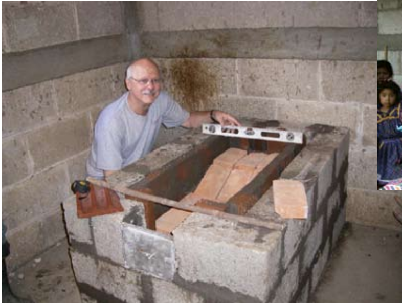
Un voluntario construye una cocina que tendrá ventilación para reducir el humo dentro de la casa.
