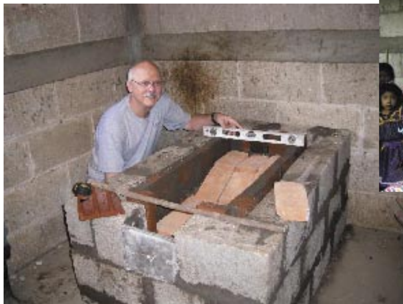
Voluntário constrói fogão que será ventilado para reduzir a fumaça dentro de casa
