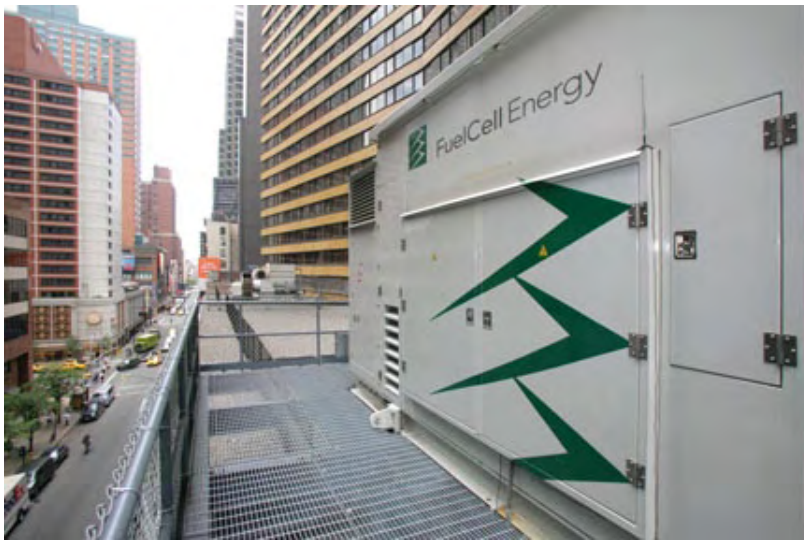
Une pile à combustible d'une capacité de 250 kW, qui fait partie de l'installation de production d'électricité et d'eau chaude d'un hôtel Sheraton à New York.
