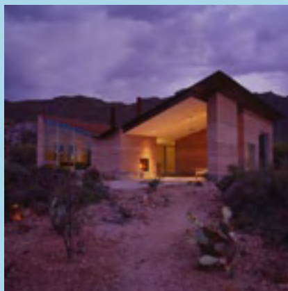
Conçue par l'architecte Roy Joy, la maison ci-dessus, qui est située dans les environs de Tucson, a des murs épais en pisé.
