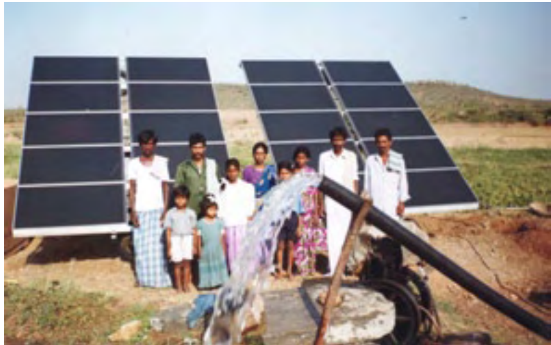
Installation d'une pompe actionnée au moyen de l'énergie solaire dans le cadre d'un projet de l'Agence indienne de développement de l'énergie renouvelable.
