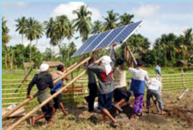
Des villageois mettent en place un panneau photovoltaïque sur l'île de Mindanao (Philippines).
