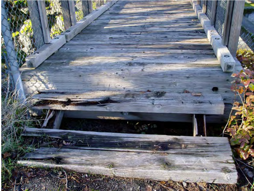
CS-5 Crossover Bridge
