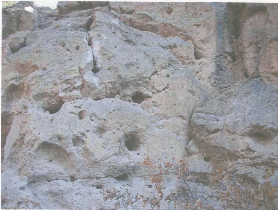
SWMU-011(d) cliff face target area.
