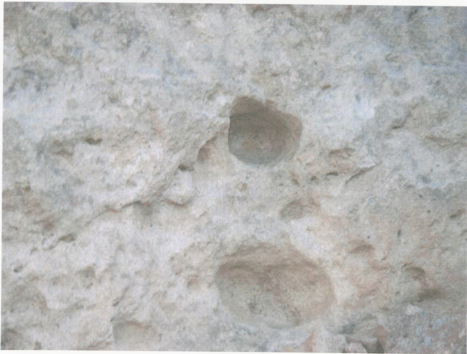
SWMU-011(d) cliff face target area.
