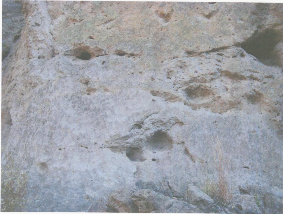
SWMU-011(d) cliff face target area.
