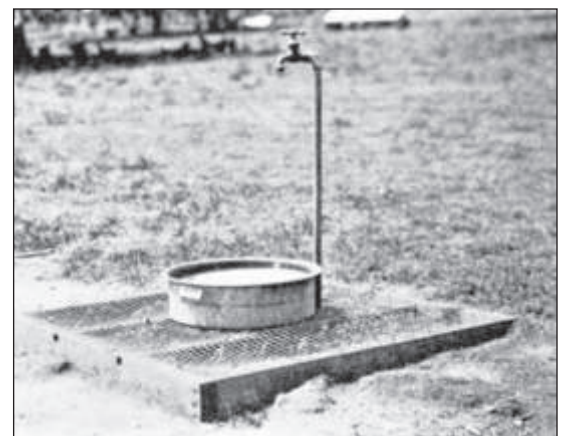
Esta instalación de los años 1930 usa una simple plataforma cubierta de alambres para prevenir zonas húmedas.
