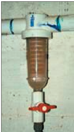
Un colador Rusco previene que el grumo alcance el agua, la válvula de salida en la parte inferior deja salir el sedimento acumulado sin tener que desarmar el colador.
