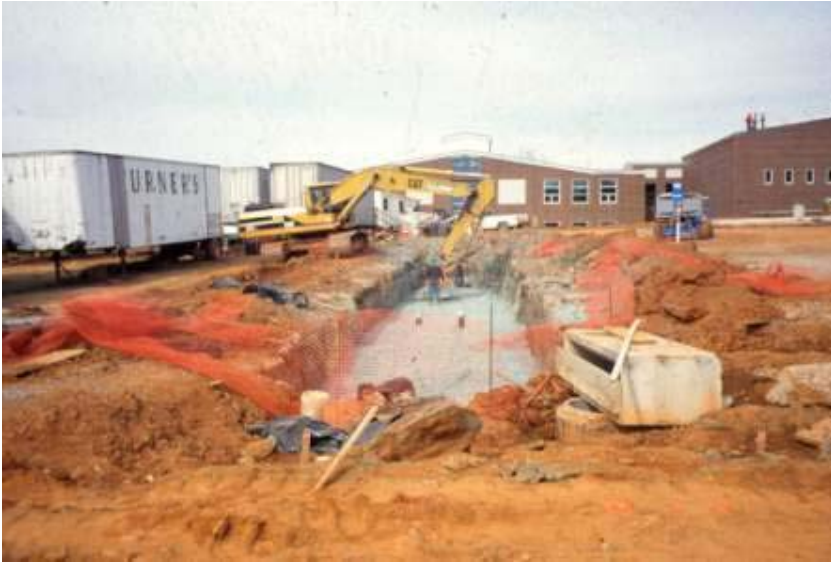
Underdrain Stone Layer
