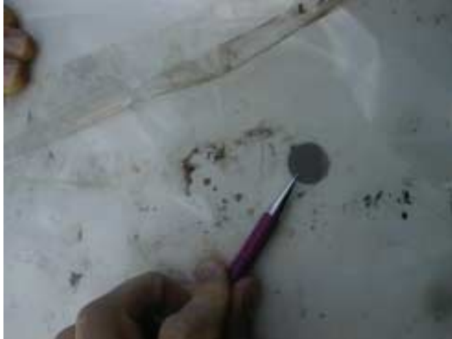
Figure 22. Vestas V44 blade protection receptor/terminal
