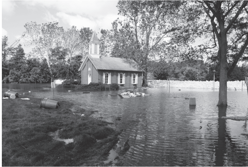
Danforth Chapel, en los terrenos de la Universidad de Iowa, está rodeada por la creciente de agua del Río Iowa. Foto tomada por Greg Henshall/FEMA.
