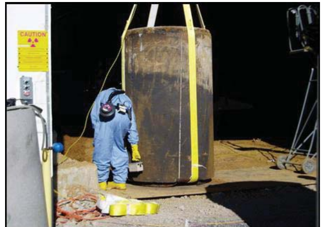
CD-4 TRU Trenches
