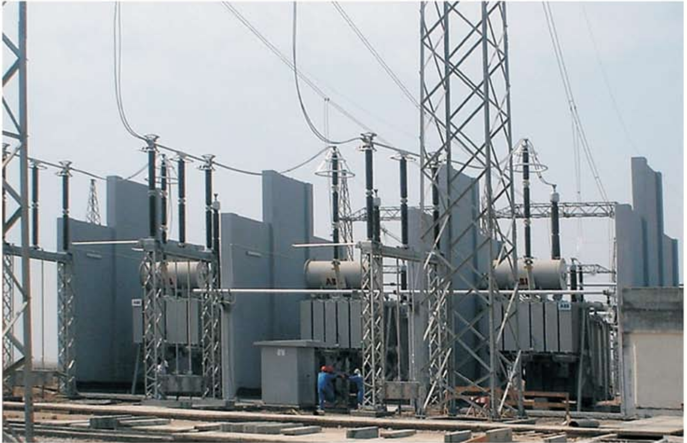
المحولات الثلاث ذات الـ 63 ميكافولت امبير وهي تعمل لخفض الفولتية من 400 كيلو فولت امبير الى المستوى الاعتيادي المستخدم محليا، تصوير أ. البحراني
