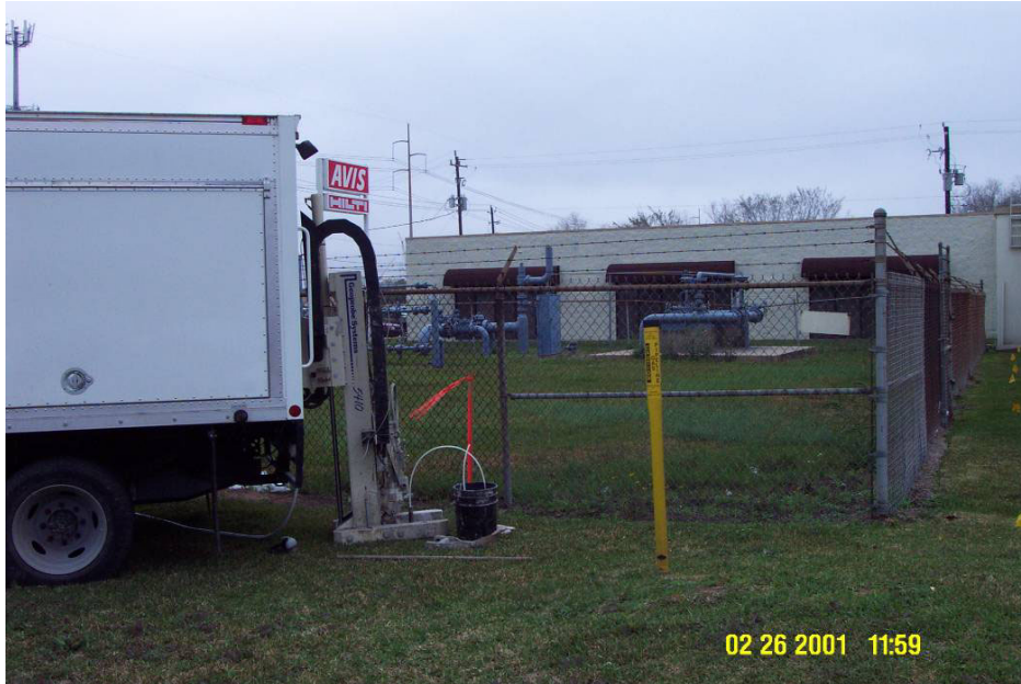
Source: Tetra Tech EM Inc.
