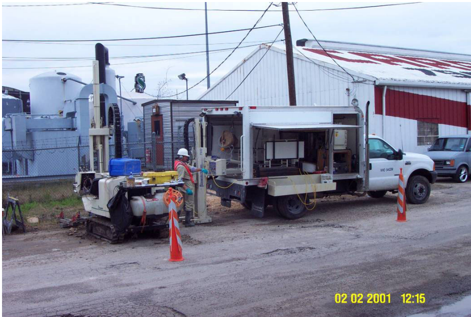
Source: Tetra Tech EM Inc.
