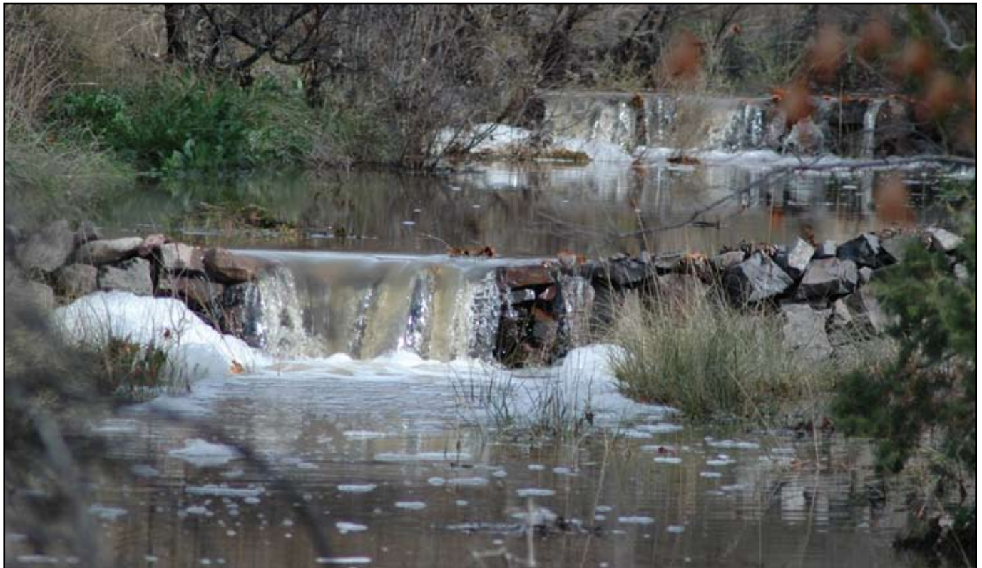
Trincheras después de la corriente.
