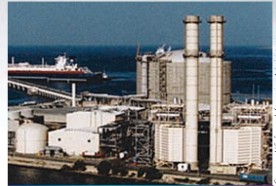
LNG terminal complex
