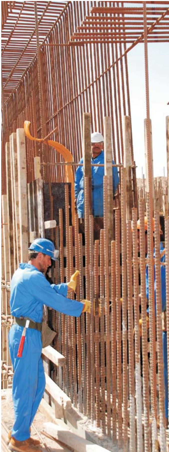
عمال بناء يثبتون القضبان الحديدية قبل عملية صب الاسمنت.
