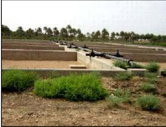
قاعات تجفيف الاوساخ في مشروع الحلة لمعالجة المياه الثقيلة.
